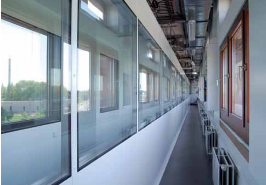
Blick auf die GMP-Anlage des Fraunhofer IZI.
